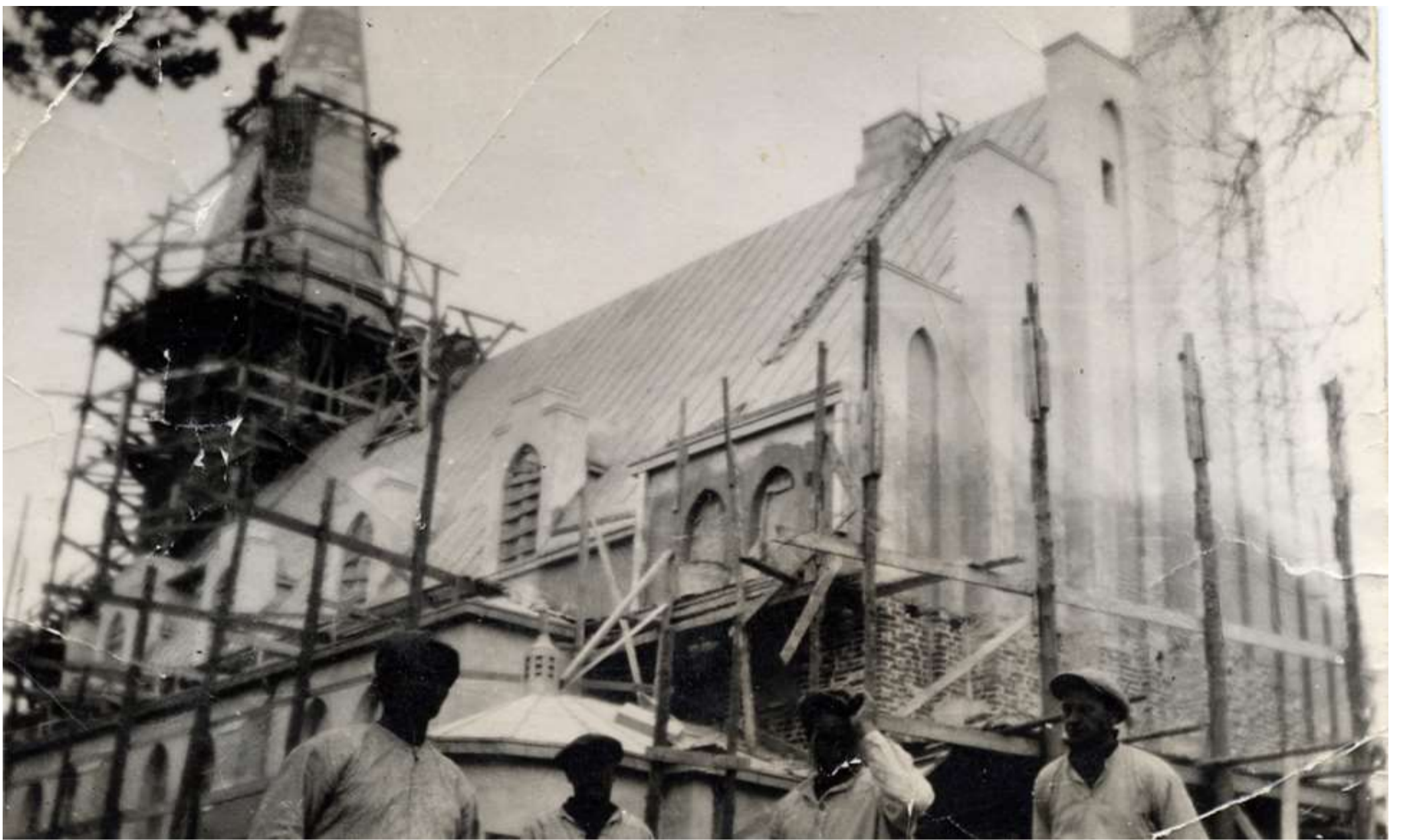
Строительство церкви в Лумиваара 1934г. Автор фото не известен Lumivaaran kirkkoa rakennetaan v.1934. Kuvaaja: Ei tiedossa
